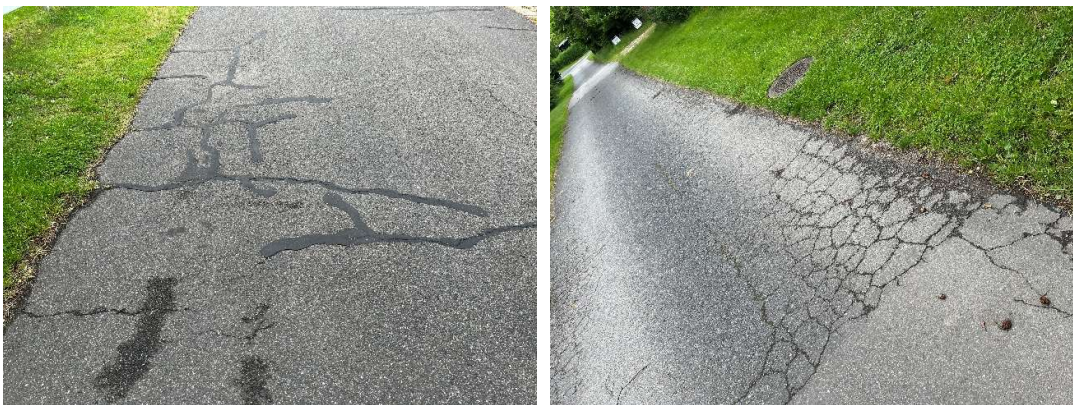
Figur 4.3.3 Krakelering: Stub-Åsen (tv) og Tuemosen (th).
