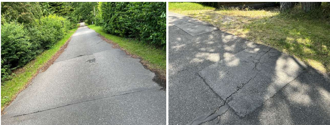
Figur 4.3.2 Revner i samlinger: Wage-Åsen (tv) og Tofte-Åsen (th).
