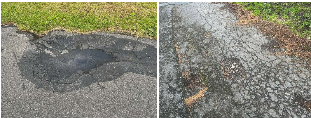
Figur 4.4.1 Slaghuller: Stub-Åsen (tv), Karl Andersens Vej (th).
